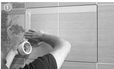
Avec une bande adhésive de largeur 20-30 mm, protéger la zone du joint mobile en laissant une fente de 2-3 mm apparente. Presser fermement la bande adhésive le long de la fente afin que le joint ne passe pas sous la bande.
