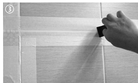
Ôter l'excédent de silicone à l'aide d'une spatule souple et lisser le joint pour qu'il ait le même aspect que le joint du carrelage.
