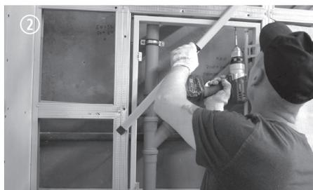
2 Fixer le cadre de la trappe avec des vis auto-taraudeuses sur le profilé métallique à travers les trous présents sur le cadre de la trappe.
