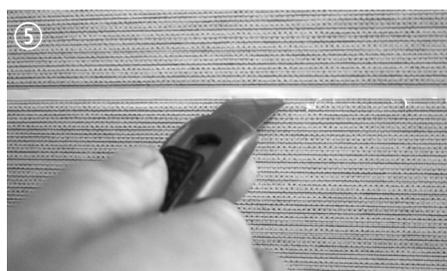
Deux jours plus tard, à l'aide d'un cutter couper le silicone à travers toute son épaisseur sous un angle de 45°. Le joint silicone doit rester en surface sur la porte de la trappe.
