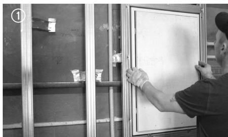
1 Installer la trappe dans l'ouverture préparée afin que le cadre de la trappe affleure la structure métallique. Caler la trappe sur l'ossature avec des coins.
