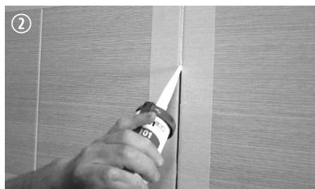
Avec un mastic silicone de la couleur du joint de carrelage, remplir la fente mais seulement sur l'épaisseur du carrelage.
