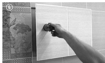
Ouvrir la porte en poussant du côté droit ou gauche de la porte de la trappe pour la déverrouiller. Si celle-ci résiste un peu, utiliser la ventouse fournie dans l'emballage.
